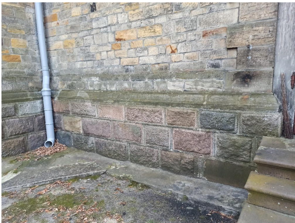
Fot. 22. Kościół w Kraśnicy, cokół granitowy i opaska betonowa przy wejściu do zakrystii, kwiecień 2023, fot.: K. Korczak.
