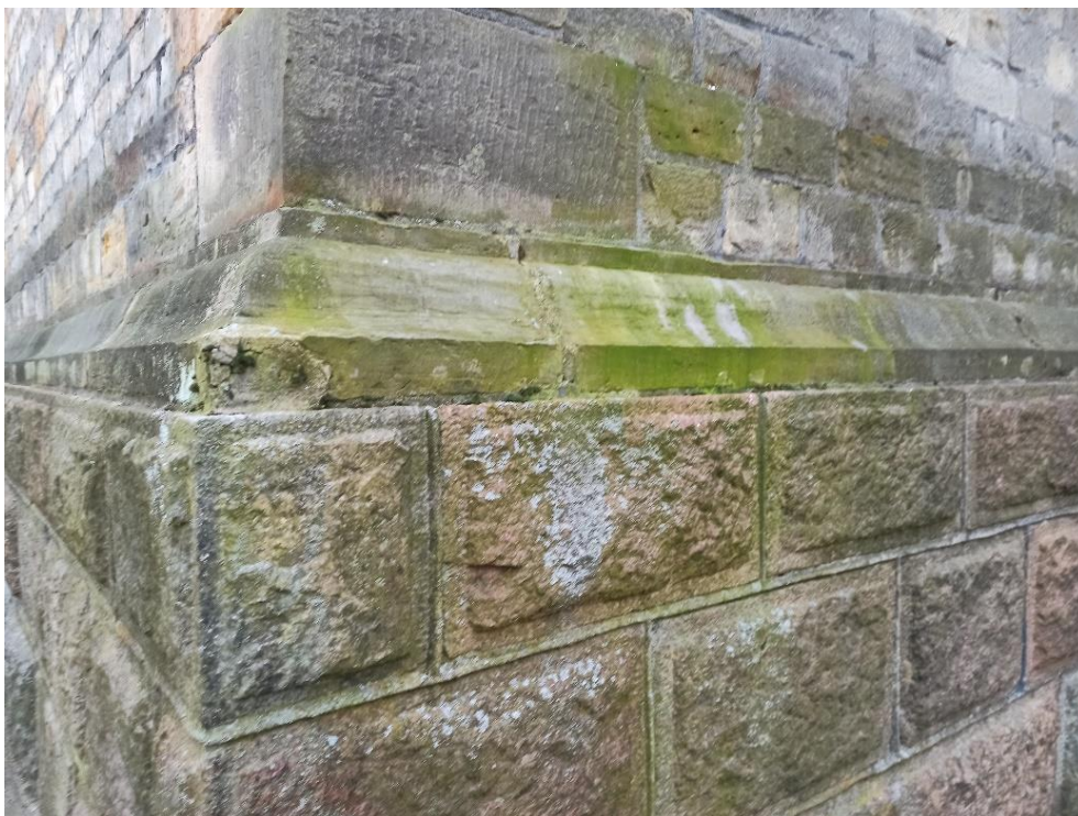
Fot. 3. Porażenie biologiczne cokołu i dolnej partii wątku piaskowcowego.
