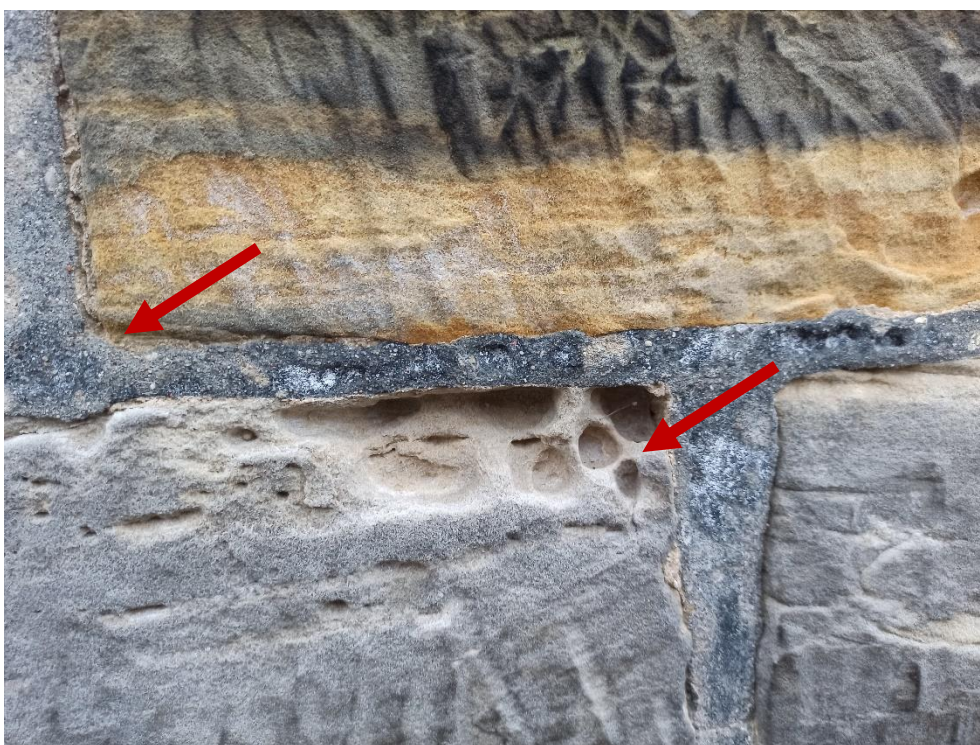
Fot. 7. Osłabianie się warstwy powierzchniowej kamienia na skutek blokowania odpływu wilgoci przez spoinę cementową.
