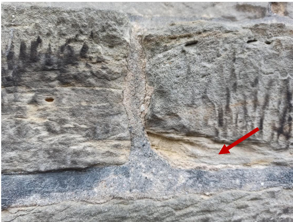
Fot. 6. Osłabianie się warstwy powierzchniowej kamienia na skutek blokowania odpływu wilgoci przez spoinę cementową.
