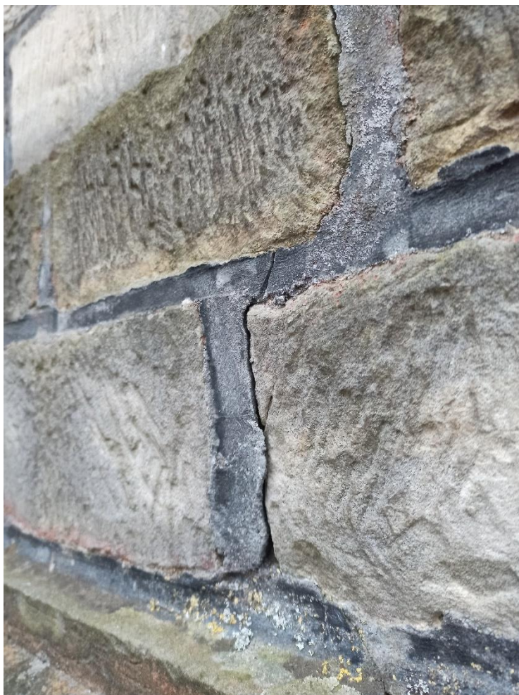
Fot. 8. Pękanie i odpadanie spoiny cementowej. Powstawanie szczelin, wpuszczających wodę do środka.
