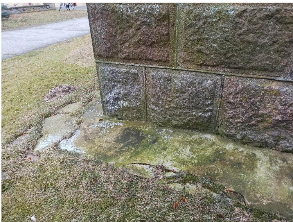
Fot. 20. Kościół w Kraśnicy, opaska betonowa wokół elewacji kościoła, kwiecień 2023, fot.: K. Korczak.
