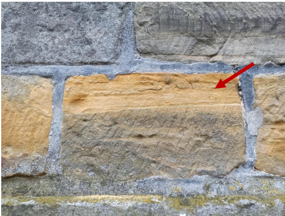
Fot. 2. Cios piaskowcowy z widoczną dezintegracją strukturalną wierzchniej warstwy kamienia.
