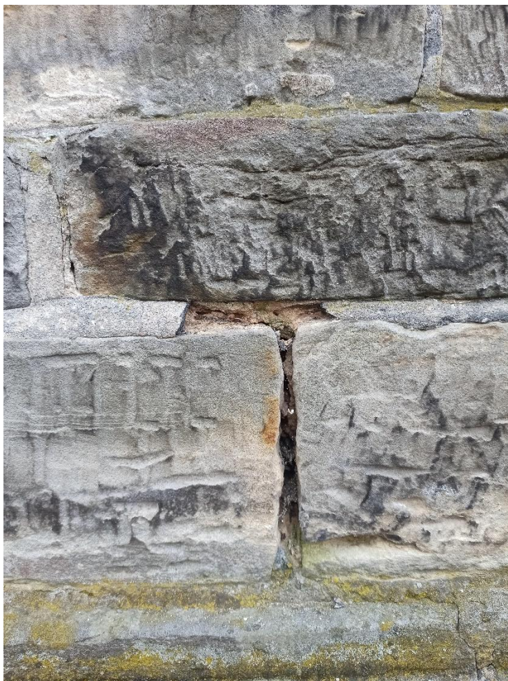
Fot. 9. Pękanie i odpadanie spoiny cementowej. Powstawanie szczelin, wpuszczających wodę do środka.
