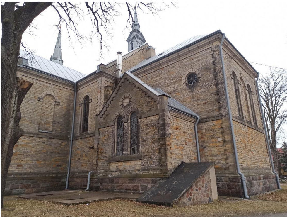
Fot. 4. Rury spustowe zakończone krótkimi kolankami i prawdopodobnie niewydolnie ukształtowane odpływy betonowe i w korycie w gruncie powodują gromadzenie się wody wokół kościoła.
