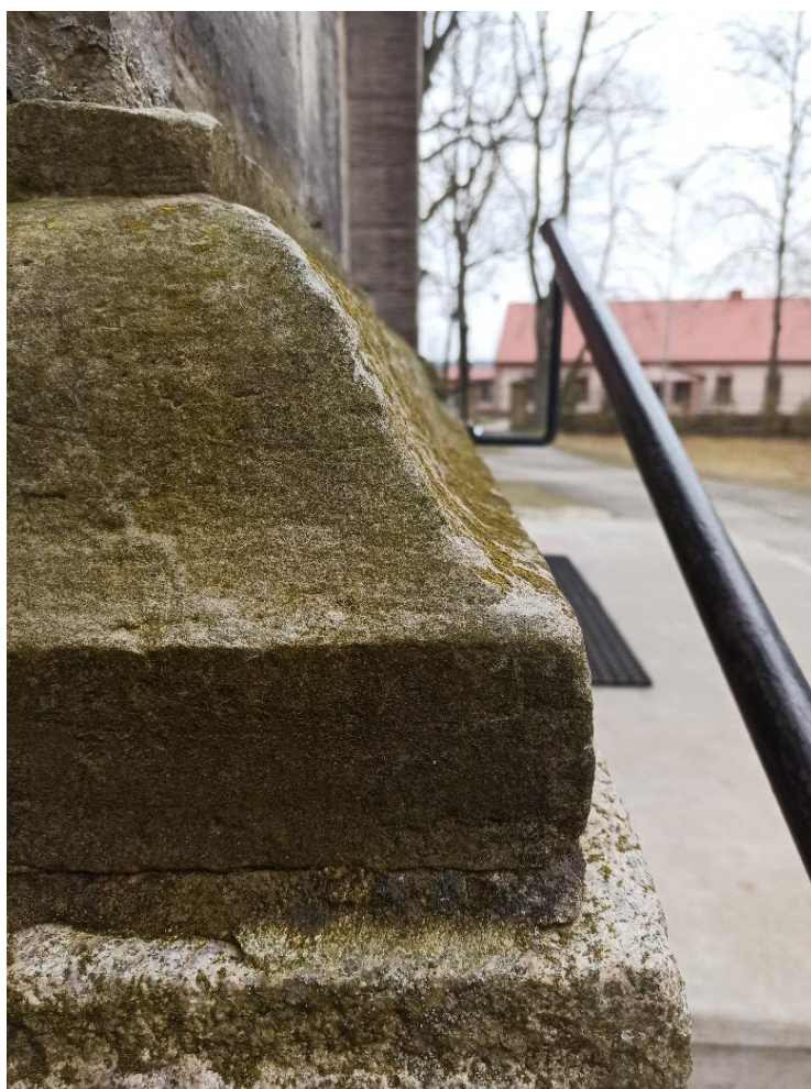
Fot. 5. Porażenie biologiczne na piaskowcowym gzymsie cokółowym.
