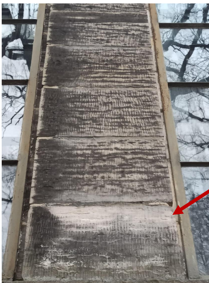
Fot. 1. Ciemne nawarstwienia na powierzchni obramowań okiennych. W dolnym ciosie zaznaczona jest dezintegracja strukturalna wierzchniej warstwy kamienia.
